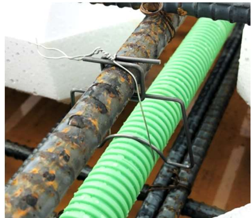
④ CD管、CDカンツリ、鉄筋を同時に結束する
